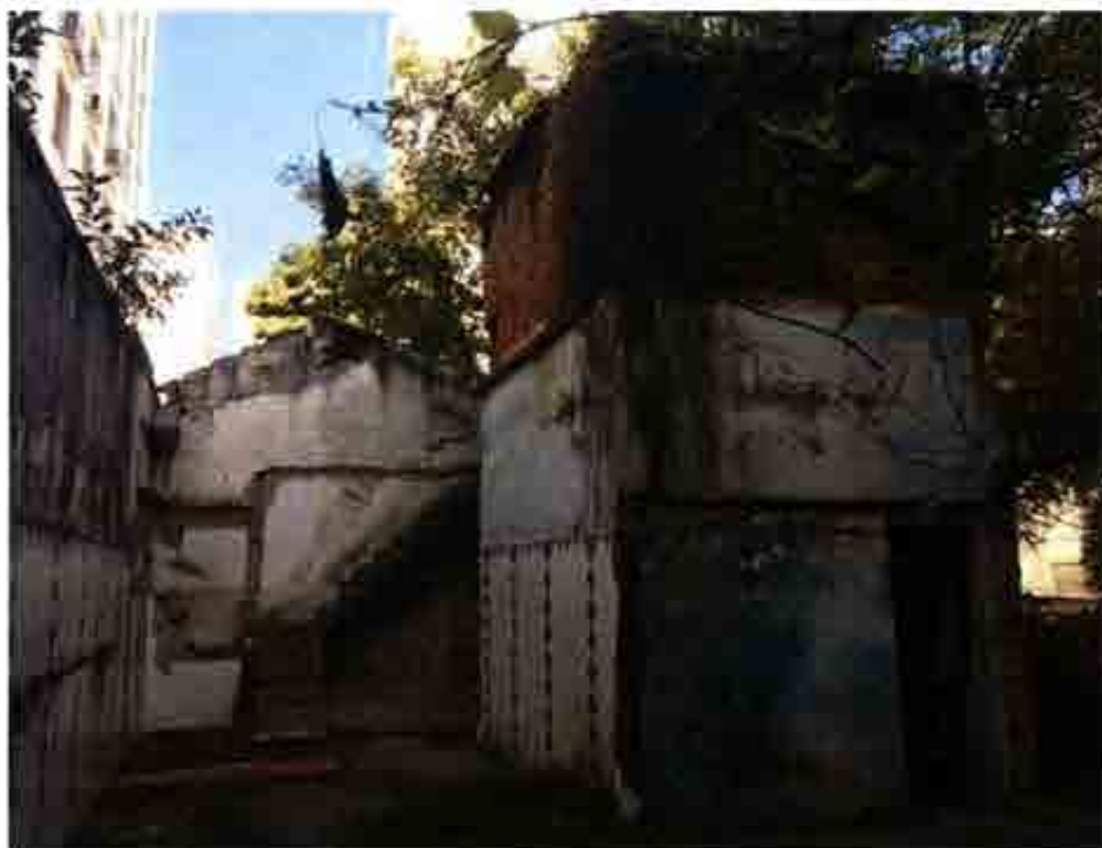
Foto 07 – Vista de parte interna do imóvel avaliando.
