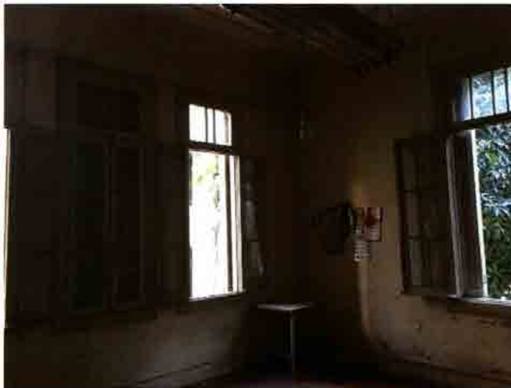
Foto 13 – Vista de parte interna do imóvel avaliando.
