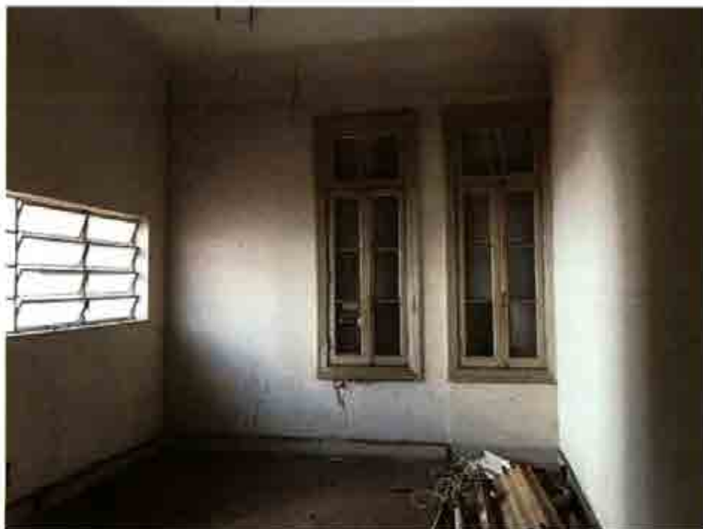
Foto 12 – Vista de parte interna do imóvel avaliando.
