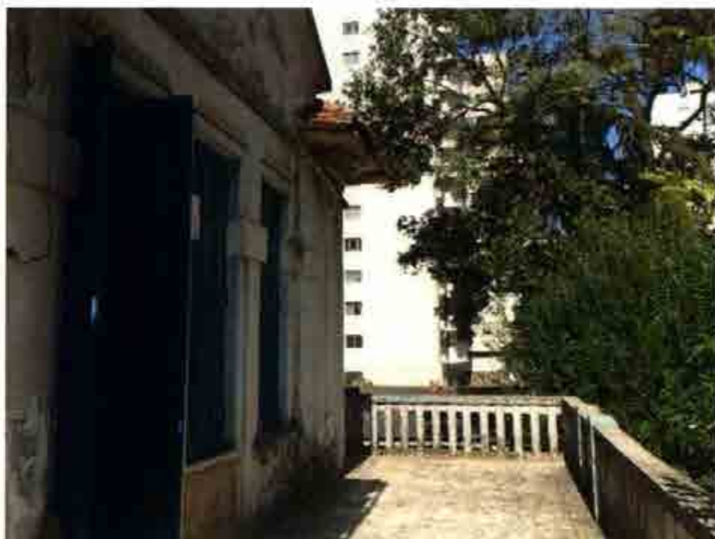
Foto 14 – Vista de parte do terraço do imóvel avaliando.
