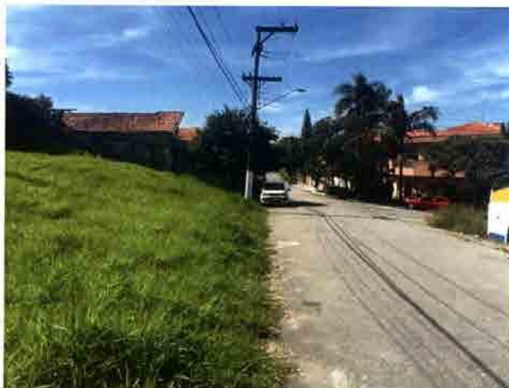
Foto 02 – Vista de parte da Rua Querino Landi.
