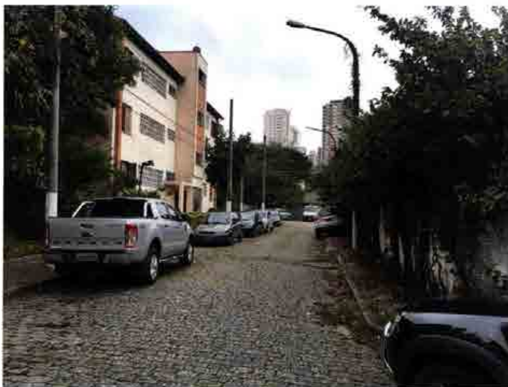
Foto 05 – Vista de parte da fachada do imóvel avaliando a direita, tomada da Rua Rui Pinheiro Brizolla.
