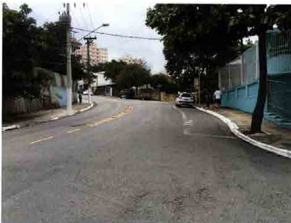
Foto 01 – Vista de parte da Rua Santa Cruz que dá acesso a Rua Carlos Gerolamo Mônaco.
