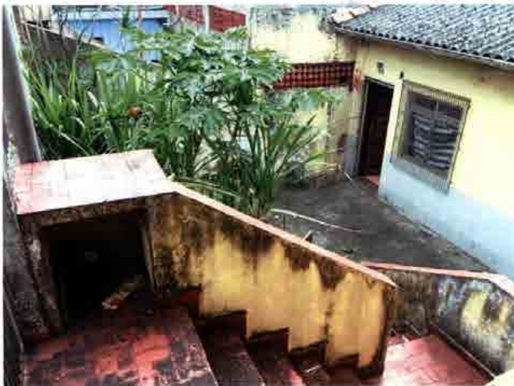
Foto 06 - Vista de parte interna do imóvel avaliando.
