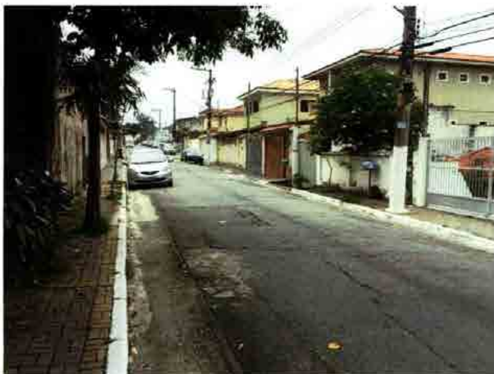
Foto 02 – Vista de parte da Rua Dr. Epaminondas Barra.
