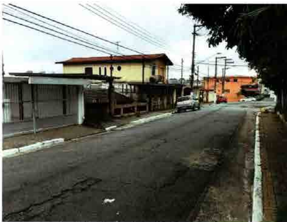
Foto 01 – Vista de parte da Rua Dr. Epaminondas Barra.
