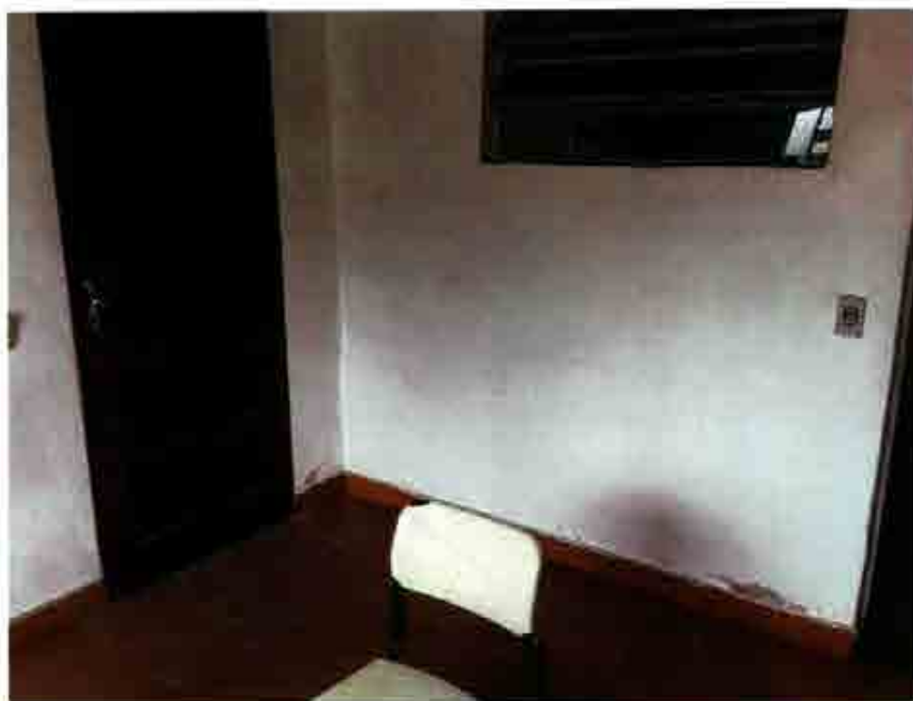
Foto 07 – Vista de parte interna do imóvel avaliando.
