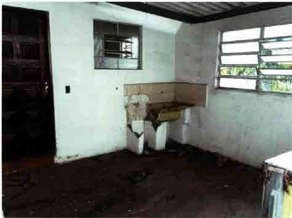
Foto 10 – Vista de área de serviço do imóvel avaliando.
