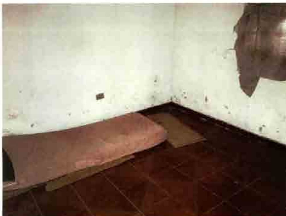
Foto 08 – Vista de parte interna do imóvel avaliando.
