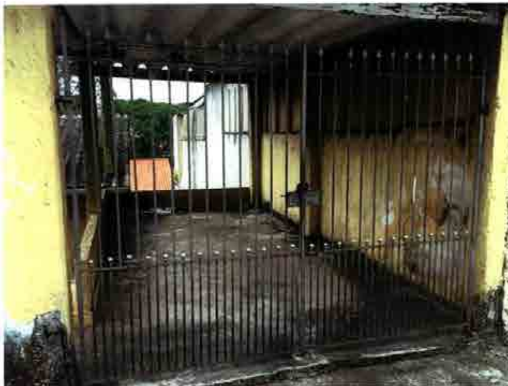
Foto 05 - Vista da garagem do imóvel avaliando.
