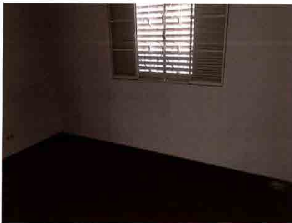
Foto 06 – Vista de parte interna do imóvel avaliando.
