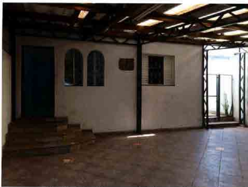
Foto 04 – Vista da garagem do imóvel avaliando.
