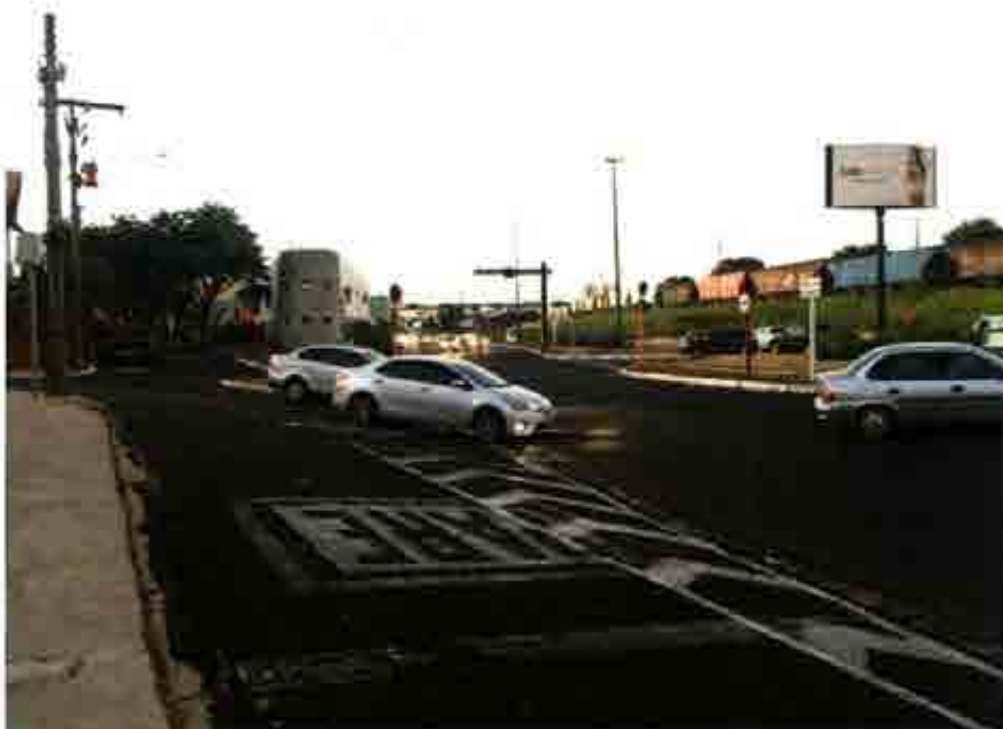
Foto 02 – Vista de parte da Rua Srg. Assad Feres.
