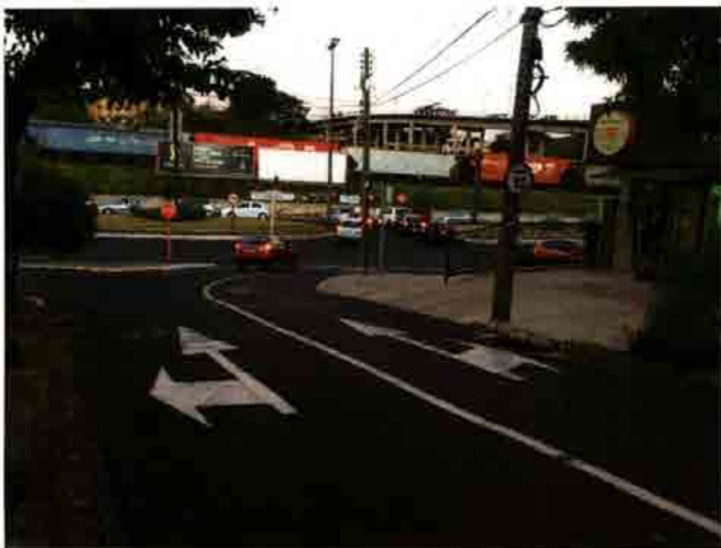
Foto 01 – Vista de parte da Avenida Prudente de Moraes.
