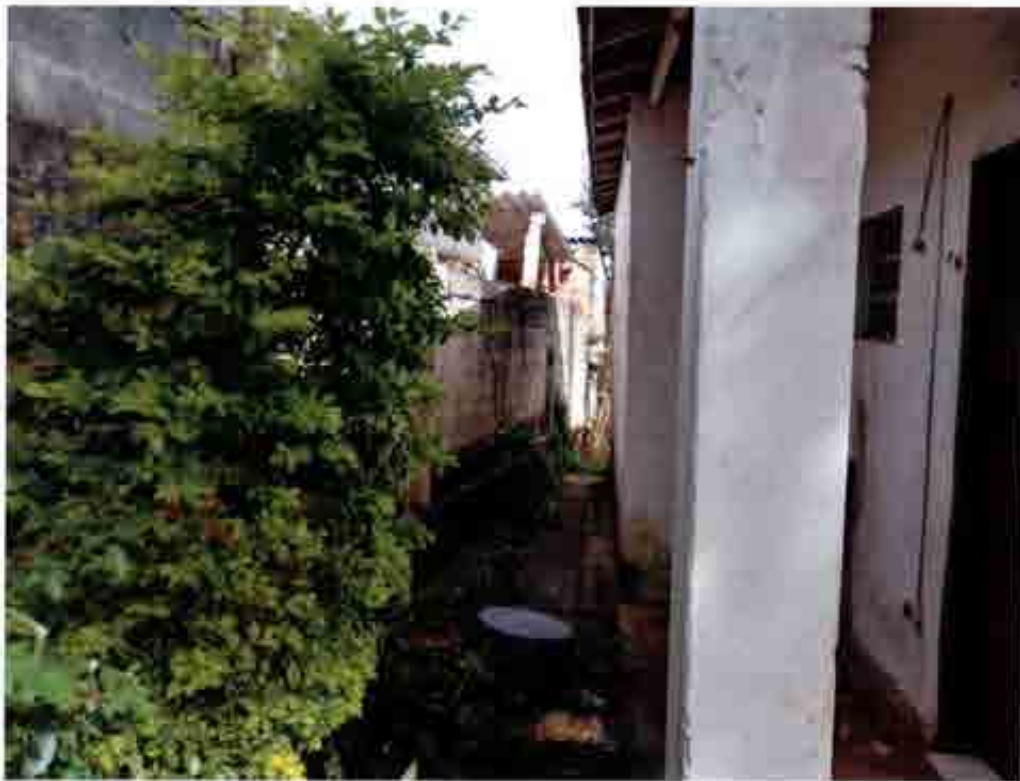
Foto 11: Corredor lateral esquerda.
