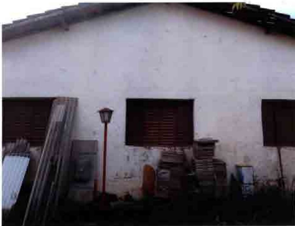
Foto 03: Fundos da casa.
