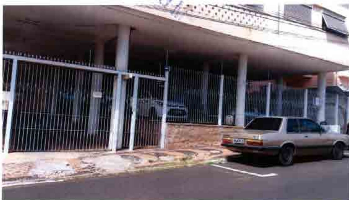
Foto 02: Vista da entrada do prédio.
