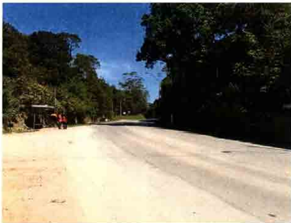
Foto 01 – Vista de parte da Estrada do Rio Acima.
