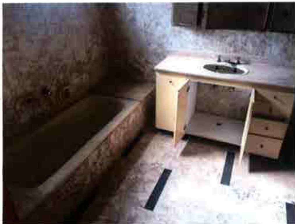
Foto 11 – Vista de parte interna do imóvel avaliando (banheiro suite).
