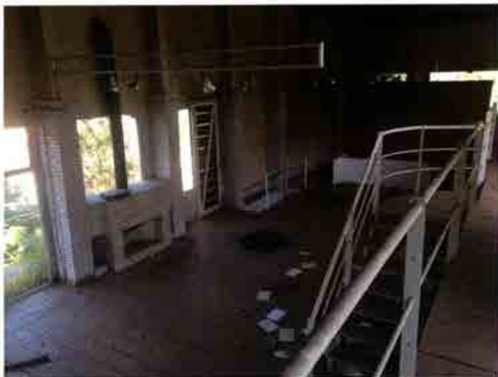
Foto 21 – Vista de parte interna do imóvel avaliando (edificação anexa).
