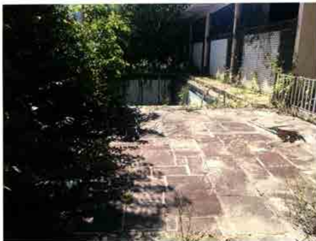
Foto 19 – Vista de parte interna do imóvel avaliando (pátio entre edificação e piscina). Notar grande presença de vegetação.
