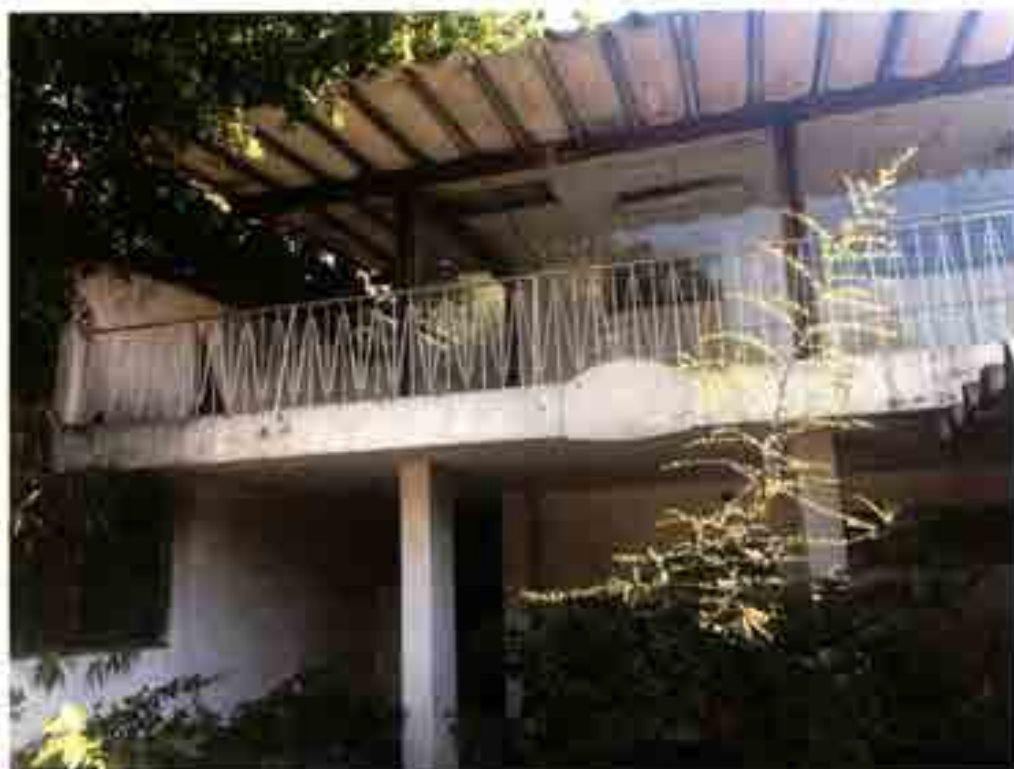
Foto 17 – Vista de parte da fachada de fundos interna ao imóvel avaliando. Notar muro de divisa lateral esquerdo.
