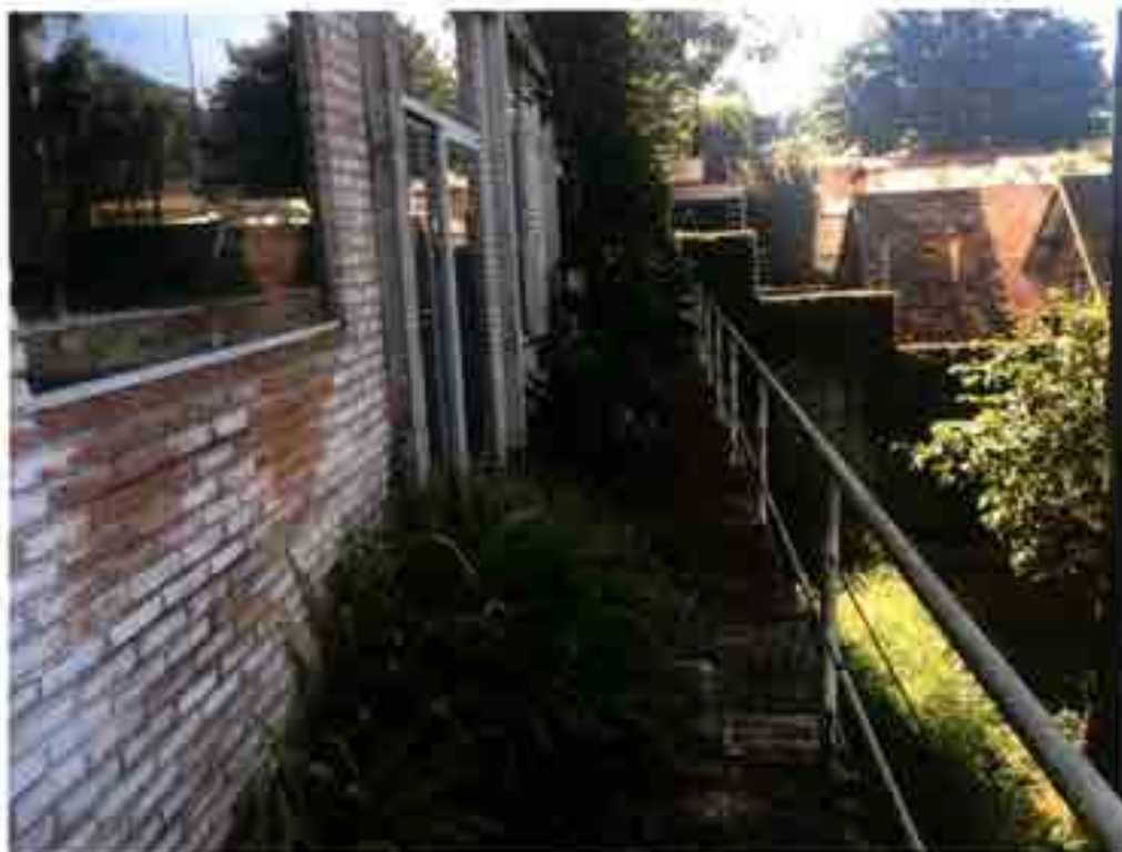
Foto 23 – Vista de parte da fachada de fundos da edificação anexa. Notar a grande presença de vegetação.
