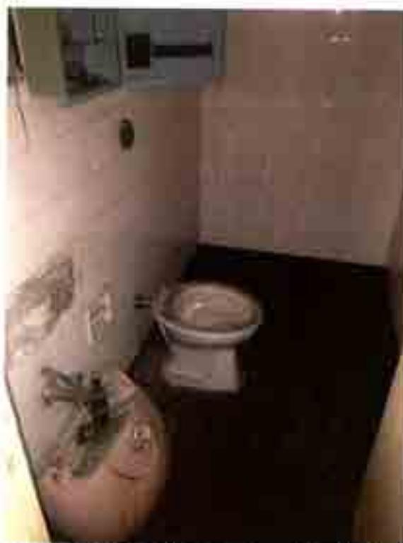
Foto 14 – Vista de parte interna do imóvel avaliando (banheiro serviço).
