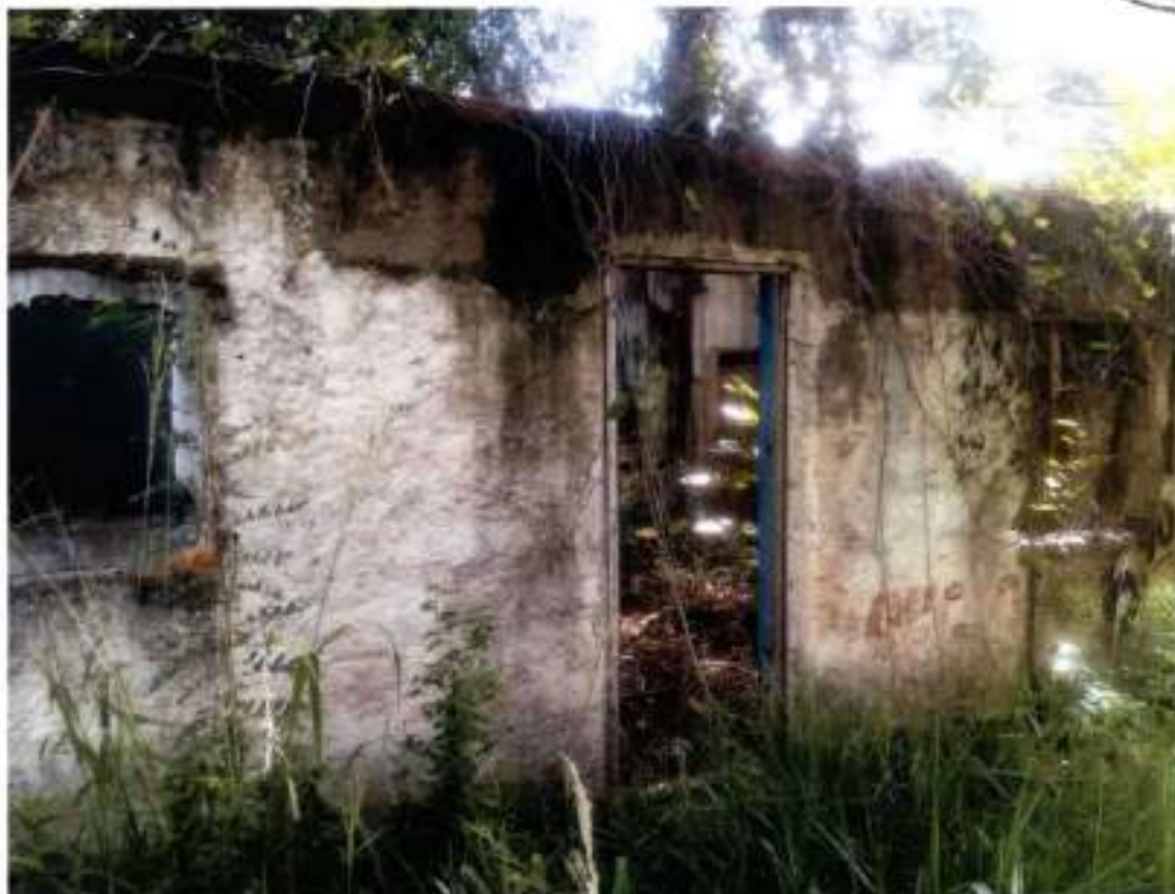
Foto 07: Só paredes de construção pré-existentes.
