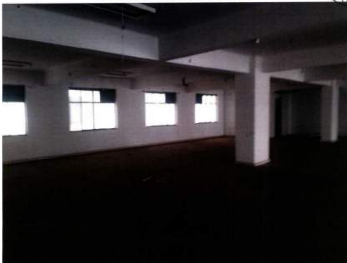
Foto 03: Vista da sala comercial.
