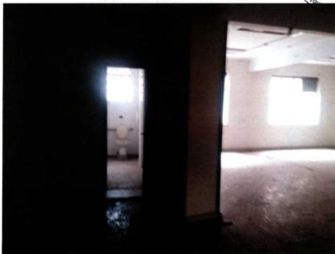
Foto 05: Banheiro e área seca necessitando reforma.
