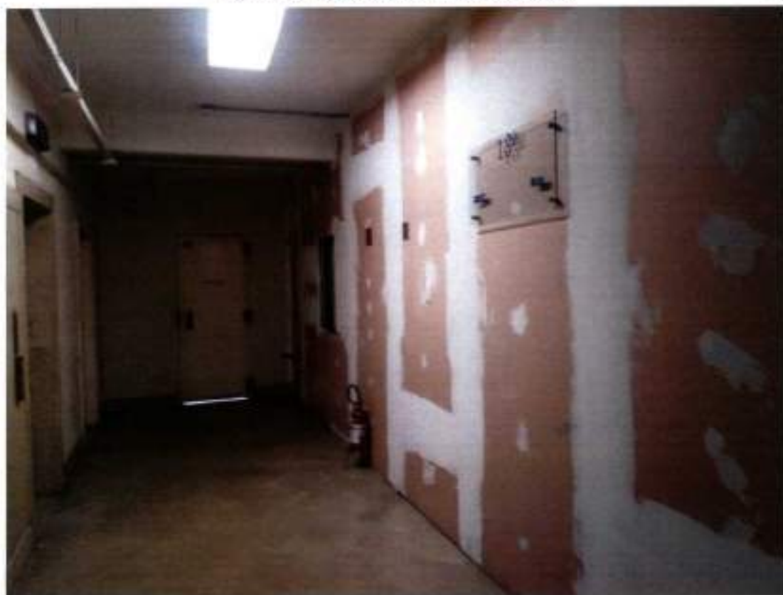
Foto 01: Vista do corredor do 13º andar .
