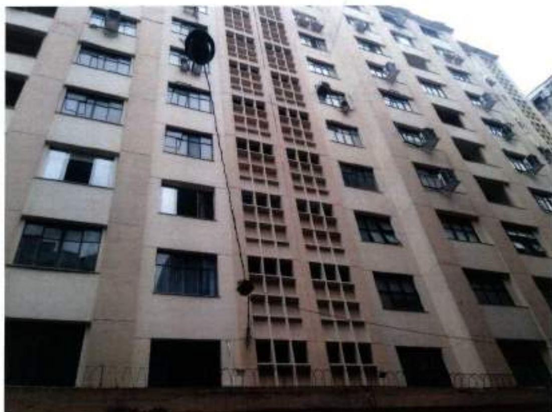
Foto 02: Fachada dos prédios.
