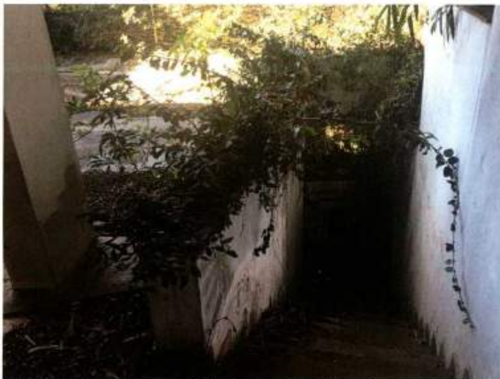
Foto 16 – Vista de parte interna do imóvel avaliando (circulação entre pavimentos).
