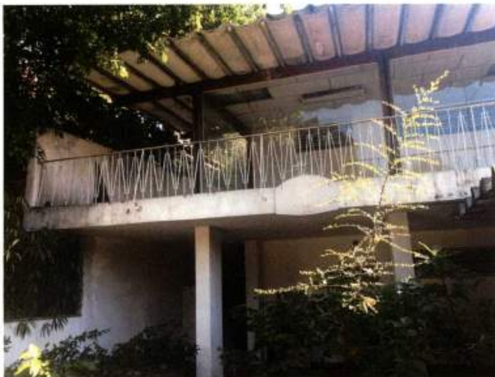
Foto 17 – Vista de parte da fachada de fundos interna ao imóvel avaliando. Notar muro de divisa lateral esquerdo.
