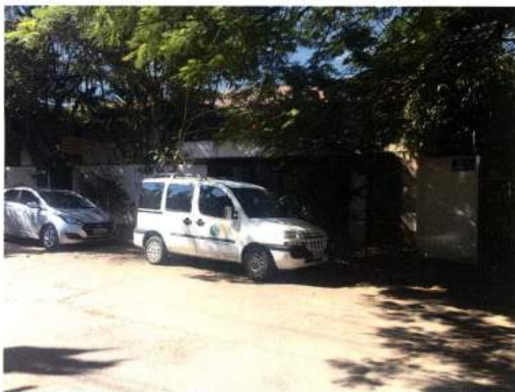
Foto 04 – Vista da fachada do imóvel avaliando.
