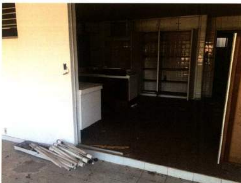
Foto 10 – Vista de parte interna do imóvel avaliando (cozinha).
