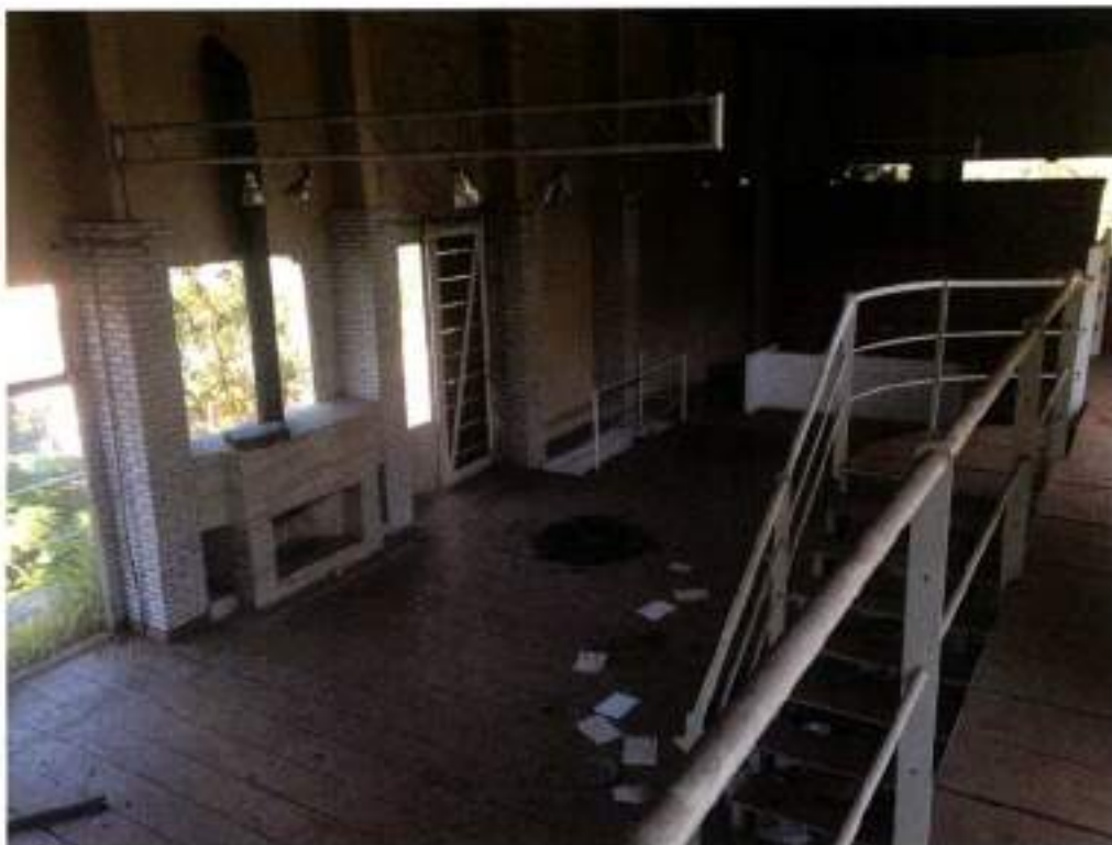
Foto 21 – Vista de parte interna do imóvel avaliando (edificação anexa).
