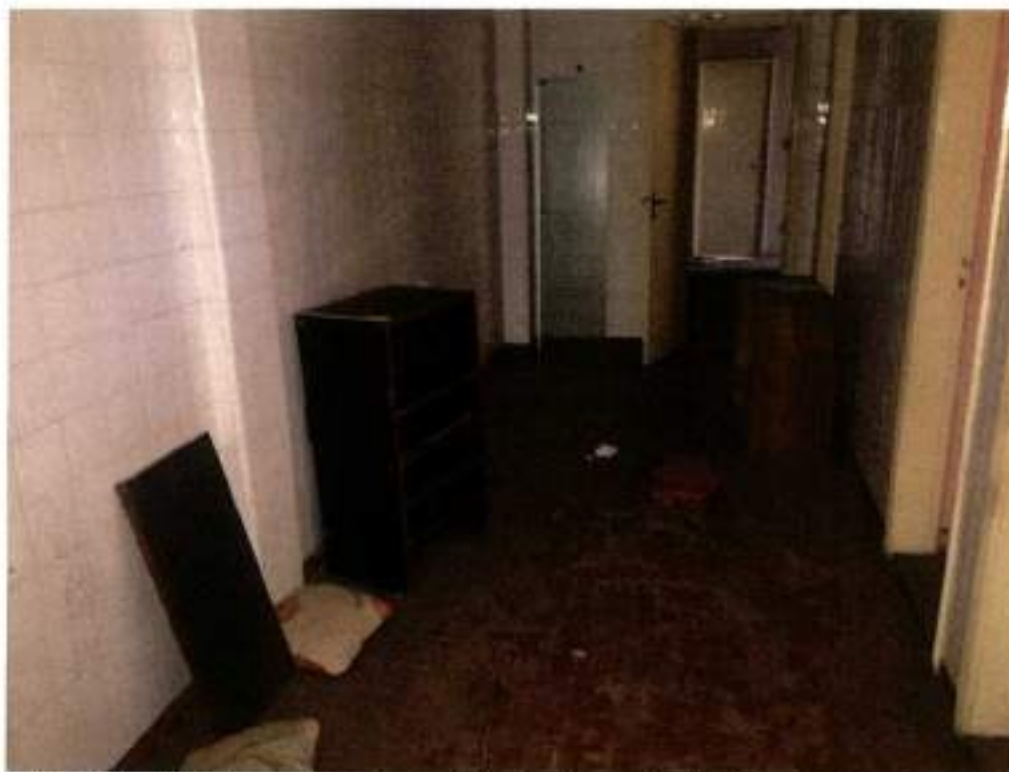
Foto 13 – Vista de parte interna do imóvel avaliando (circulação sub-solo).
