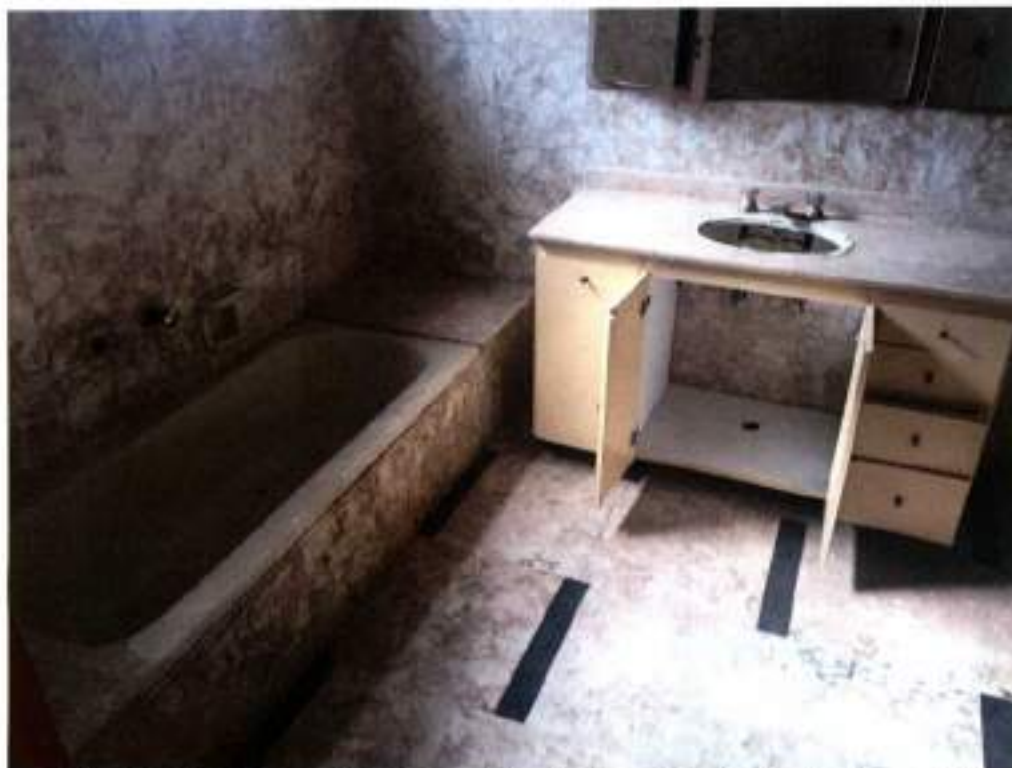
Foto 11 – Vista de parte interna do imóvel avaliando (banheiro suíte).
