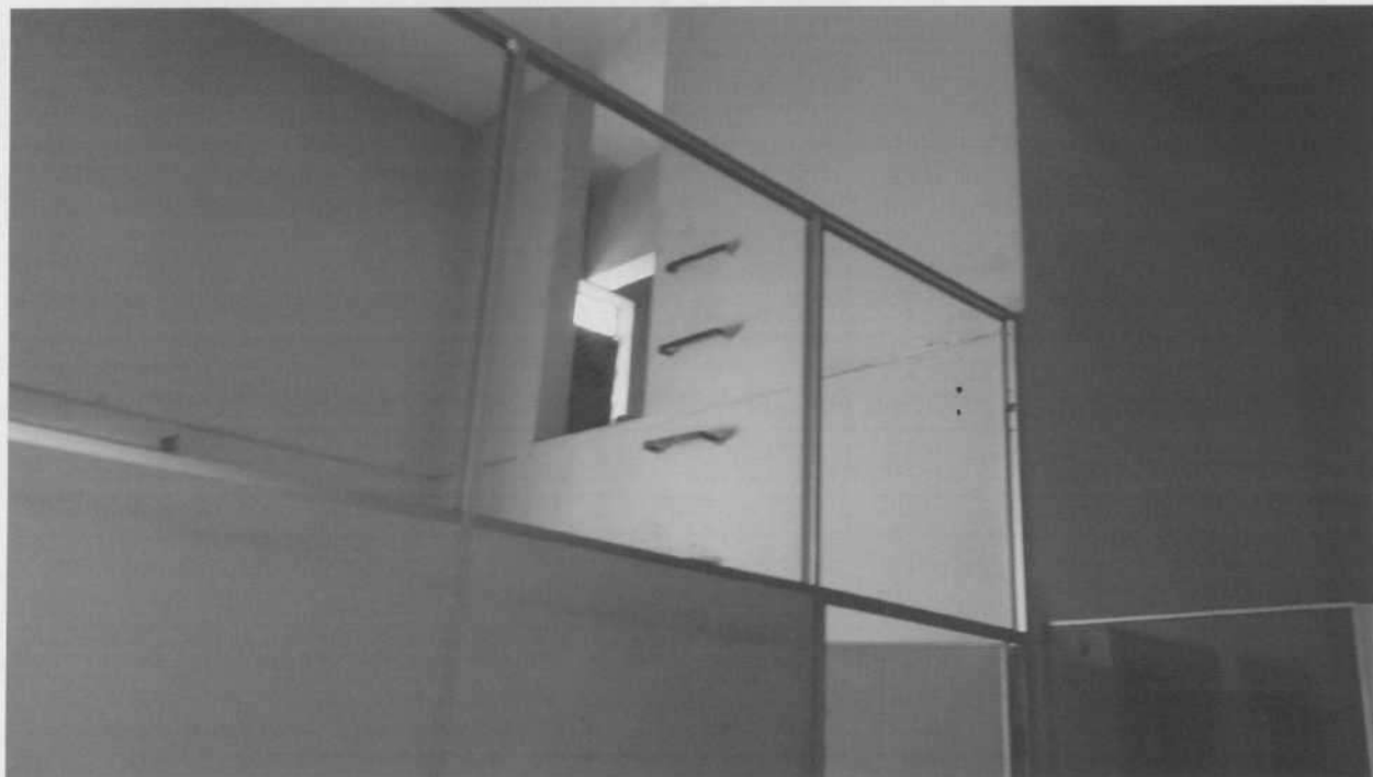
Foto 04: Acesso a caixa d'água.
