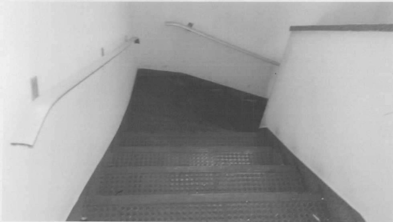
Foto 08: Escada em leque com piso de borracha.
