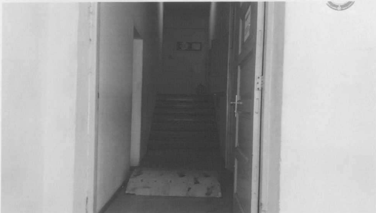
Foto 02: Vista da escada no prédio na entrada.
