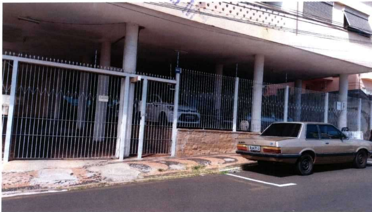
Foto 02: Vista da entrada do prédio.
