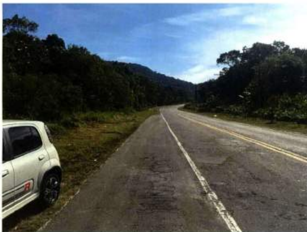
Foto 04 – Vista da gleba avalianda.
